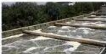
污水污泥除臭
